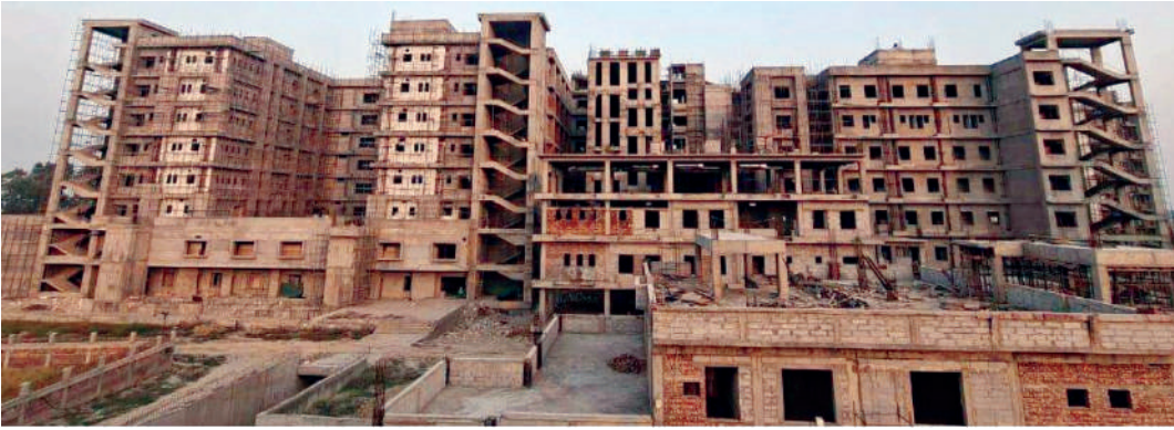
निर्माणाधीन भगवान परशुराम राजकीय मेडिकल कॉलेज कैथल। (छाया: एसबी)
